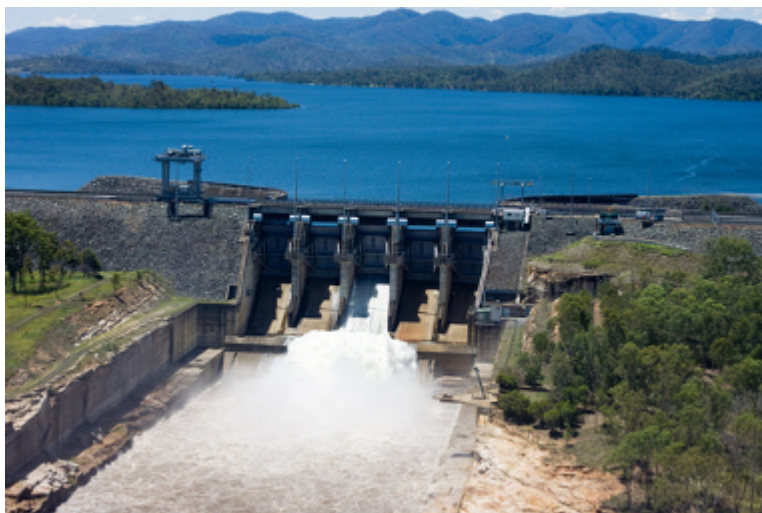
Hidrelétrica de Wivenhoe, no Reino Unido
